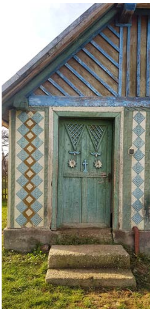
Anexa 5. Portiță de intrare în șură. Decor similar cu cel al porților de șură.
